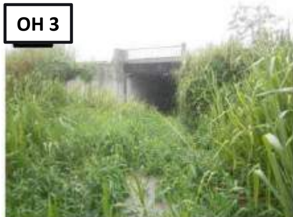
source : étude hydraulique g2C 2015 Figure 6 : ouvrage de franchissement
