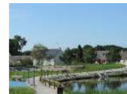
Saint -Etienne-de-Montluc (44)_Bassin de rétention
